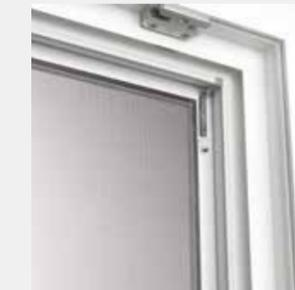
Spannrahmen ISE in der Ansicht von innen mit der Befestigung über Feder-Einhängewinkel
